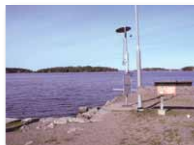
Semaforen vid Lillsveds brygga är placerad nära en brant och stenig sluttning vilket gör den svåråtkomlig och utgör en fallrisk.
