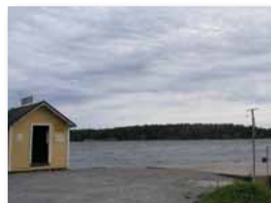
Sträckan mellan väderstuga och till bryggdäcket kantas av en stenig och lite brant sluttning och kan utgöra fallrisk.
